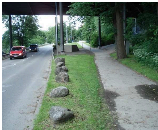
Söder Mälarstrand med Västerbrons bropelare och gångbanan längs vägens södra sida, riktning österut.
